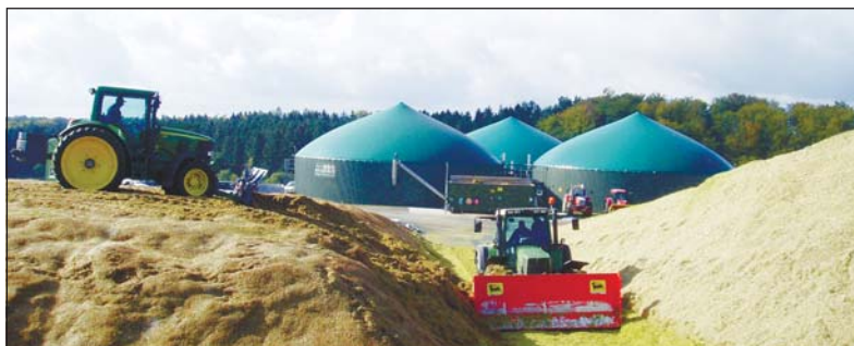
Die Biogasanlage Fuchsstadt in Franken.
