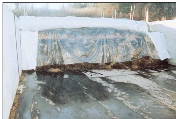
Das Silo ist gut abgedeckt: mit Kautschukfolie vorne und die Silo- und Gewebefolie oben.
